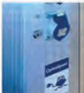
Amsterdam heeft eind 2012 twee smart grids geïnstalleerd voor elektriciteit.
