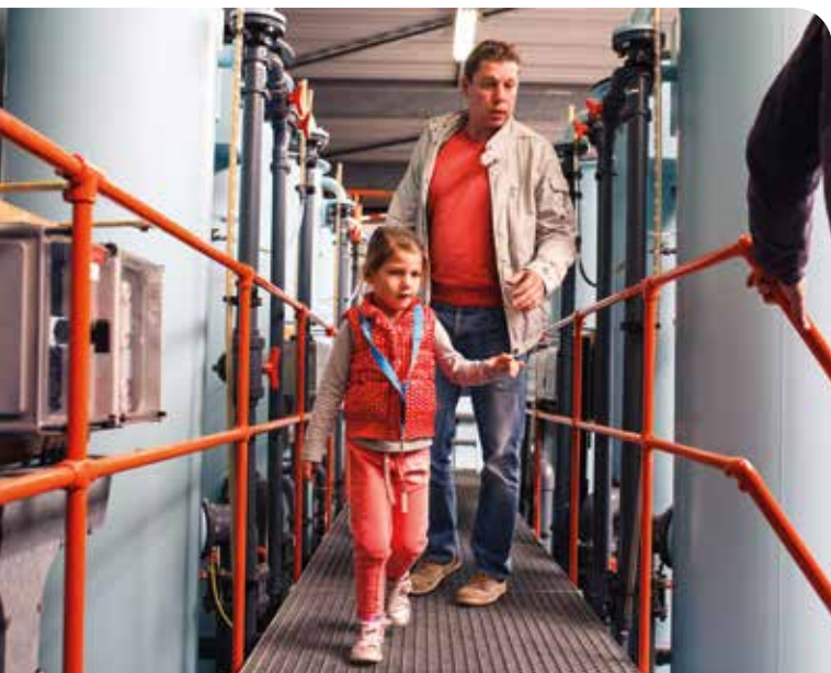
Exclusieve rondleiding door de waterzuiveringsinstallaties van Waternet in Amsterdam
